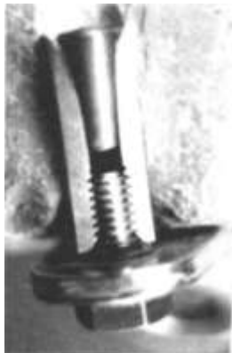
Secció d'una clavilla d'expansió clavada a la roca
